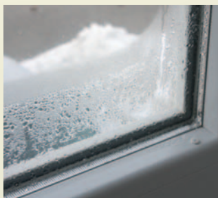
Příklad srážení vlhkosti na studeném povrchu okenní tabulky.
